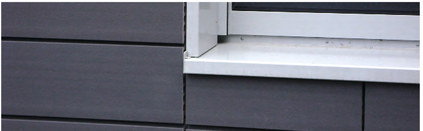
Detail Fensterbank/Laibung gekantet
