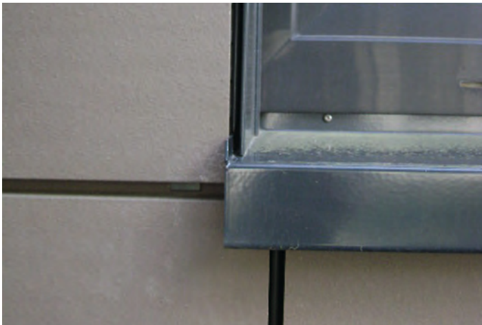
Detail Fensterbank/Laibung gekantet
