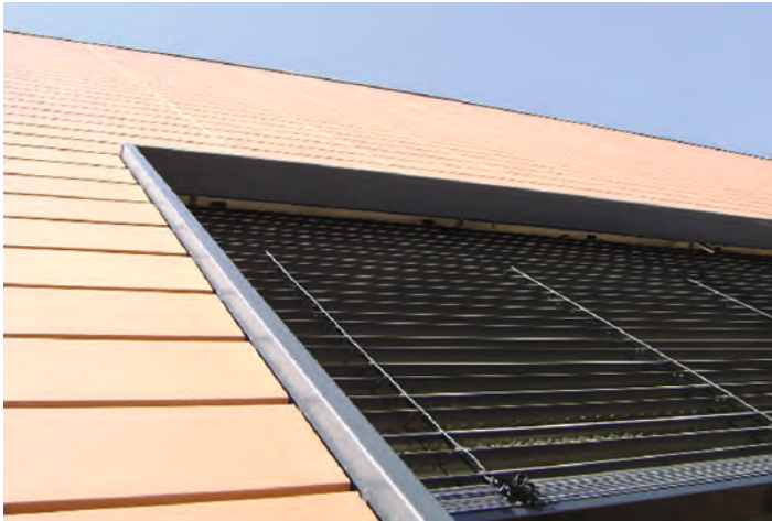
Detail Fensterbank/Laibung umgeschlagen
